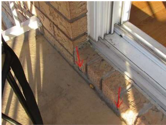
Taches de coulisse observé au linteau sous le balcon du 3ième
